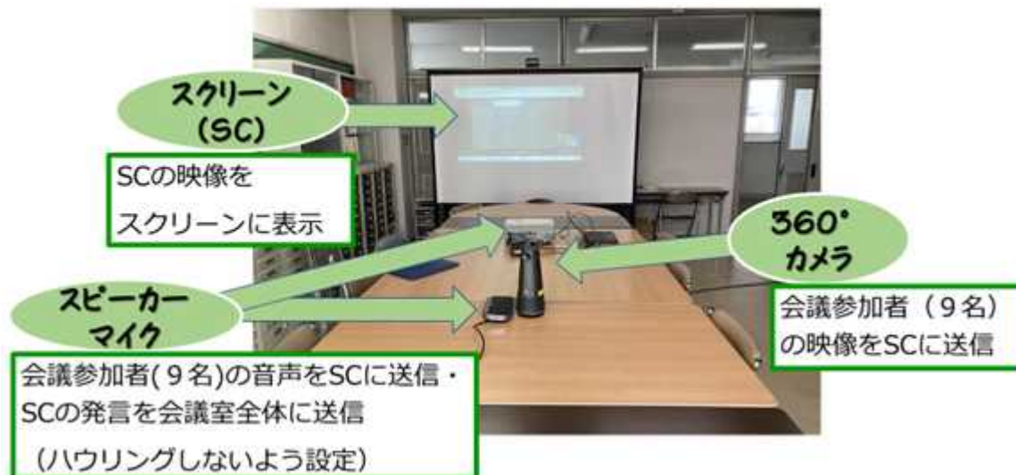
図 15 会議室の ICT 器材設置状況
